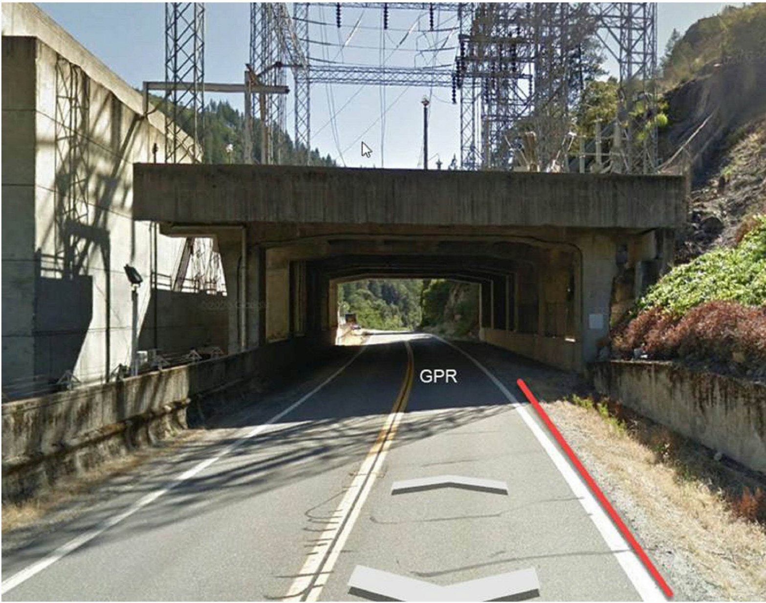
UPRR Rock Creek
